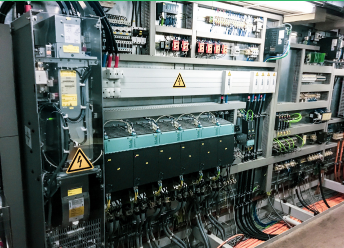
Umrichter der Liniantriebe vor und nach dem Retrofit
